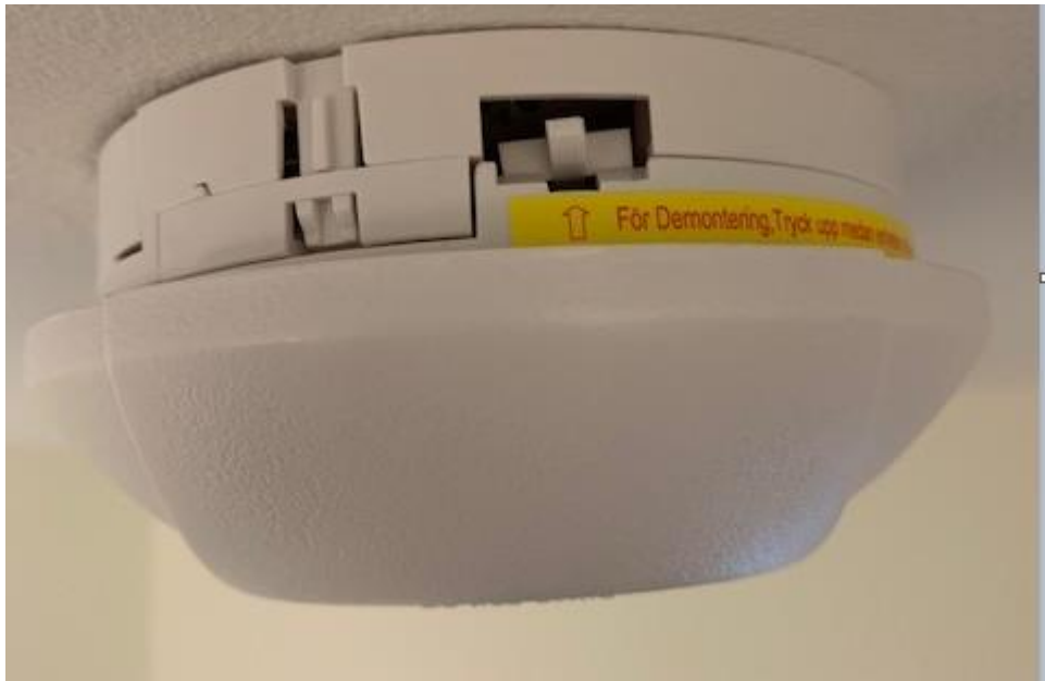
Figur 4. Tryck spärren uppåt och dra samtidigt brandvarnaren sidledes, för att frigöra den från fästplattan
